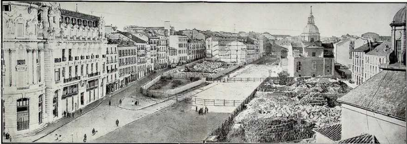
Vista panorámica del terreno que ha de ocupar el primer trozo de la Gran Vía y estado actual de las obras de demolición, en su aspecto desde la calle de Alcalá
